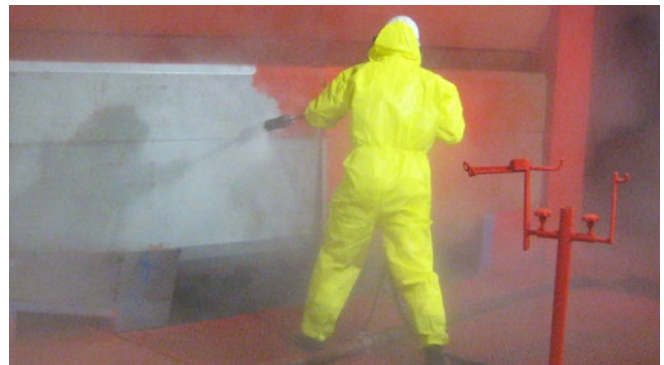
Abb. 20 Reinigung mit einem manuellen Hochdruckreiniger
